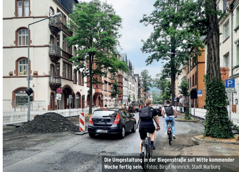
Neue Fahrbahndecke, neue Markierung, mehr Sicherheit für alle ist das Ziel.
